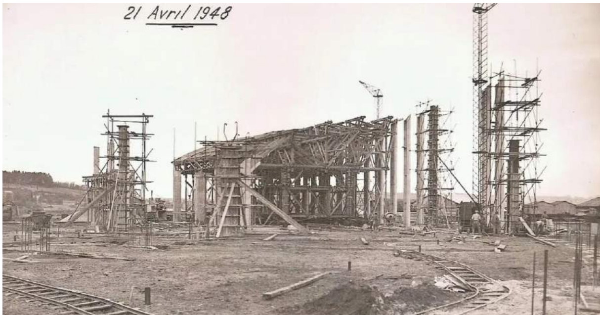
Photo du chantier de construction de la rotonde de Chalindrey, en 1948
